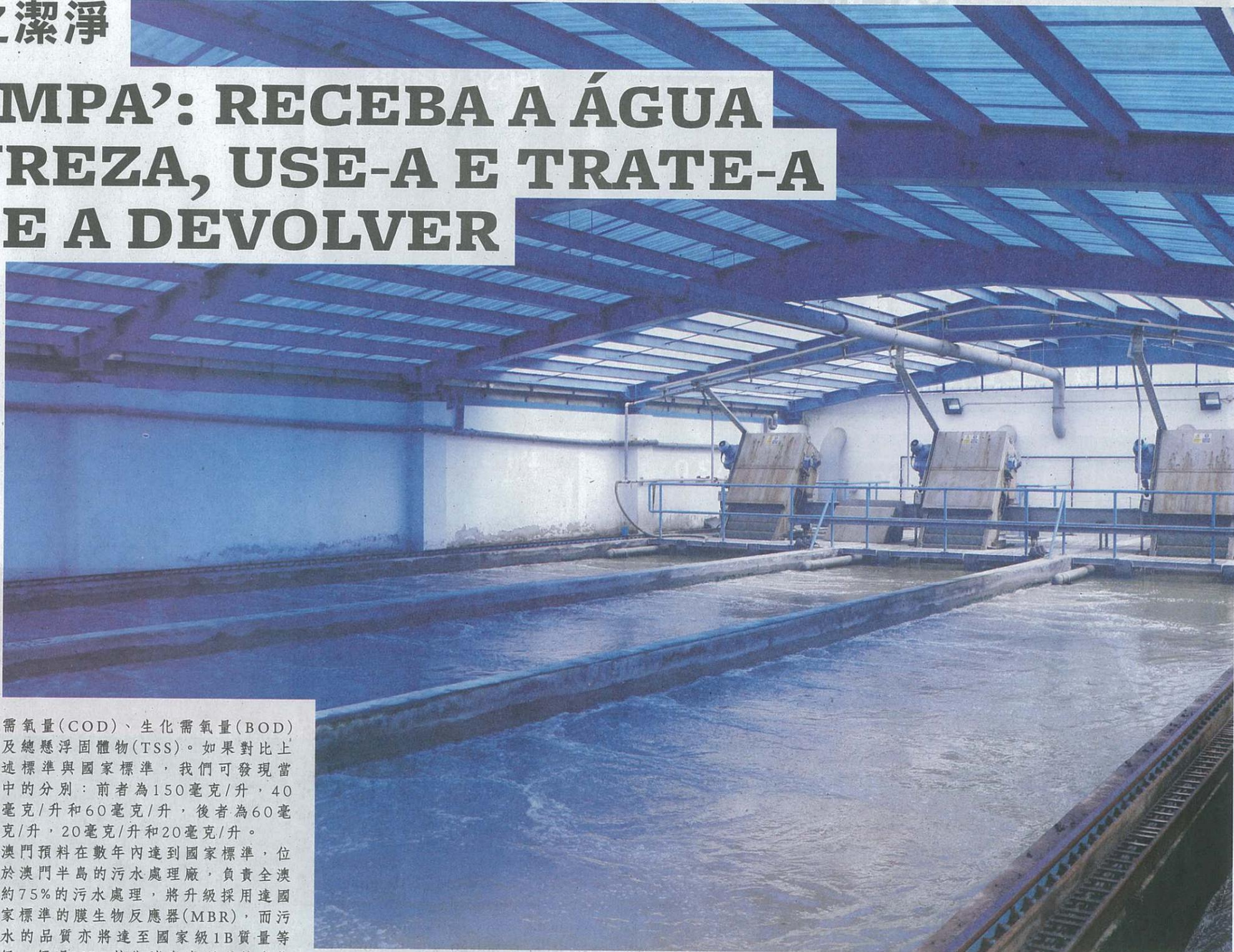
理由二級處理廠排出的水，務必令所排出的水能達到所要求的標準。分別位於澳門半島、氹仔及路環的污水處理廠均為二級處理廠，三間污水處理廠的營運始於90年代後期，採用當時的標準來處理污水。該標準遠遠不及所設定的1B質量級別，也是城市污水廠的排放未能達到指標(GB18918-2002)。通常用於測量污水中污染物濃度的參數包括：化學
